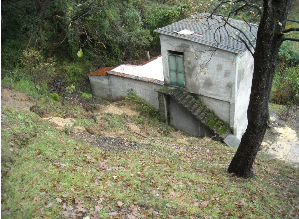
Foto n° 26 e n°27 – Frana per colata rapida in loc. Fenosa
