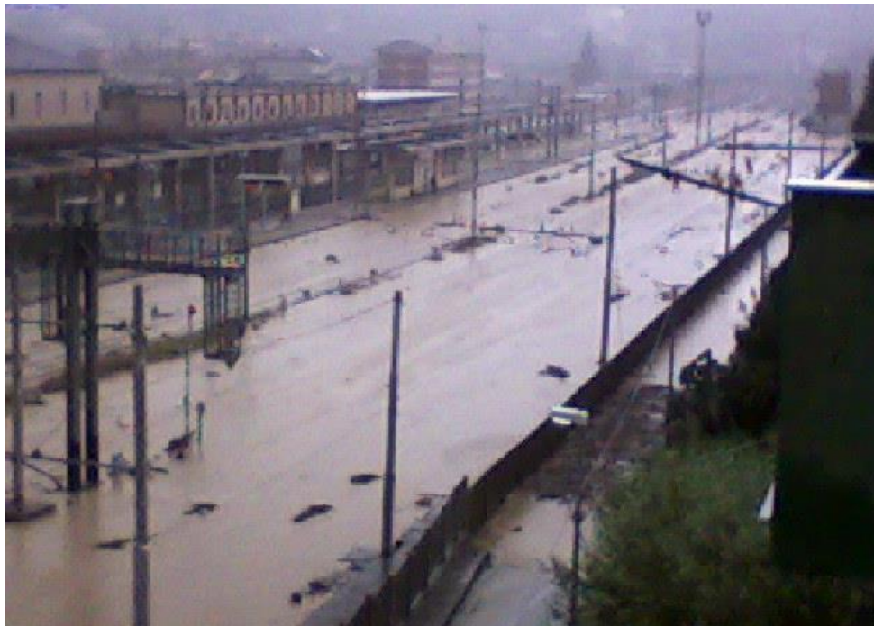
Foto n° 18 – allagamento della linea ferroviaria il 14 Ottobre 2010
