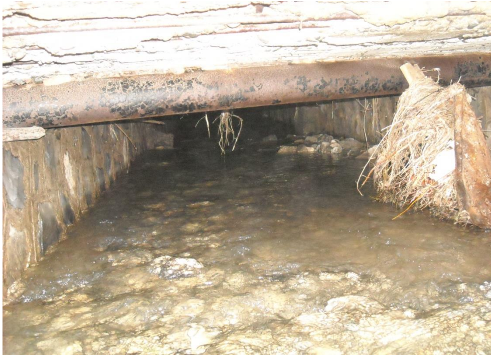
Foto n°22 – cordolo in c.a. di una rete di sottoservizi che attraversa la sezione tombata del v.ne S. Ischitello in Via Kennedy
